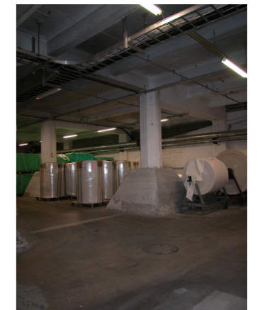
1956 kellari, lattiatasoa on laskettu. Samat 8-kulmaiset pylväät.
