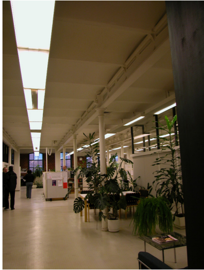
Alakerran rakenne toistuu toisessa kerroksessa.
