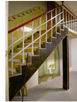
1892 tiiliseinät 1928-29 rakenteet. Portaassa niitattu rautarakenteet. Maa-laukset uusia.
