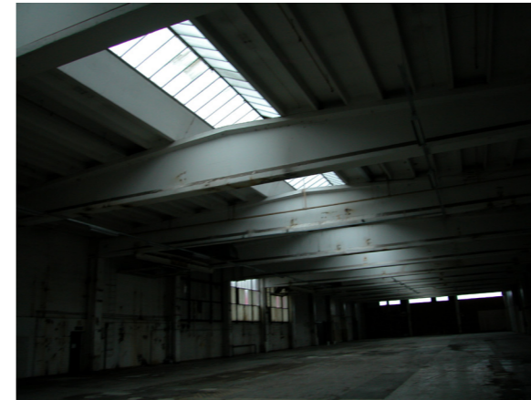
1965 Kaksi harjapalkkia vierekkäin. Tilan keskellä betonipilarilinja. Kaksi laajaa avointa tilaa vierekkäin toisessa kattoolyty. Rakennusta voi muokata vapaasti.
