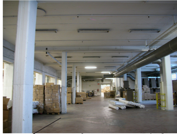
Betonipilari ja alalaatta.
