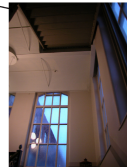
Leikattu kappaholvi portaan jatkoa varten.
