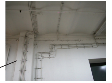
Kappaholvi I-palkit, pila-reiden paikalla betonipila-ri. Betonipilarin sisällä on luultavasti valurautapilarit, jonka voi olettaa näky-västä detaljista (pilarin liittymä palkkiin).
