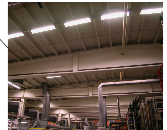
Vuonna 1970 sijoitettiin vierekkäin kaksi harjapalkkia tilan keskellä betonipilarilinja. Rakennusta voi muokata vapaasti.
