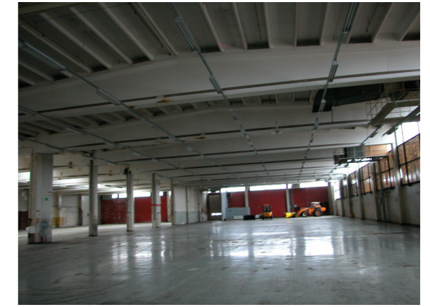
1965 Kaksi harjapalkkia vierekkäin. Tilan keskellä betonipilarilinja. Kaksi laajaa avointa tilaa vierekkäin toisessa kattoolyty. Rakennusta voi muokata vapaasti.
