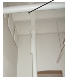
Valurautapilari, palkki ja kappaholvi.
