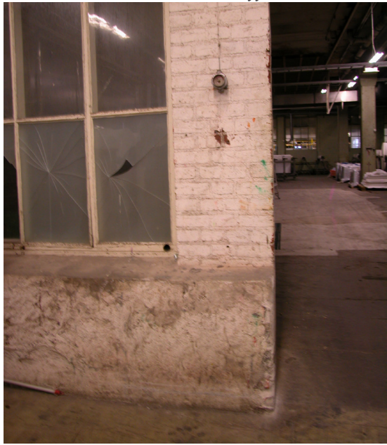
Vanha 1896 ulkoseinä näkyy rakennuksen sisällä.
