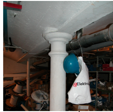
Matala kellari 1909 osan alla. kappaholvi valurautapilarit ja -palkit, holvin alapuoli betonoitu. Betonin päällä on tiiliholvi, joka näkyy läpiviennestä.
