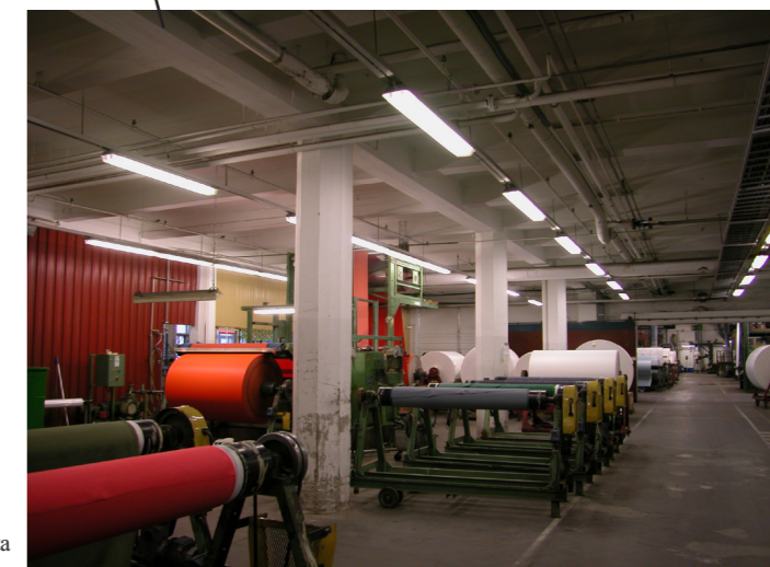
1956 8-kulmainen betonipilari, palkki, betonilaatta
