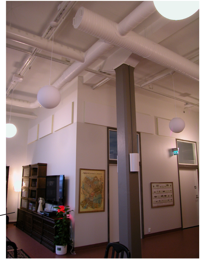
Kolmannessa kerroksessa on uusi vanusten palvelutalo. Rakenteina on kuten, alemmissakin kerroksissa, hennebique järjestelmä.
