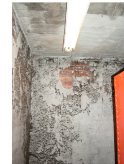
Tornin neljännessä kerroksessa on niitattu vesisäiliö. Korotus on tiisiseinäinen ja yläpohja on valettua betonia.
